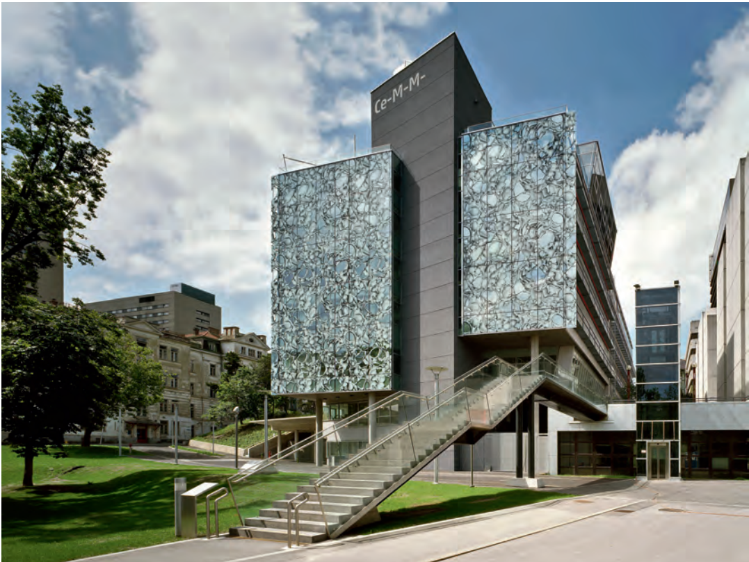
142. CeMM-Gebäude auf dem Gelände des Universitätsklinikums AKH Wien
